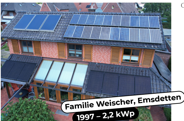
Abb 07 — Die Solarthermie-Anlage und die Solarmodule oben sind von 1994 und 1997. Seitdem wurden weitere Module auf allen verfügbaren Flächen ergänzt. •
