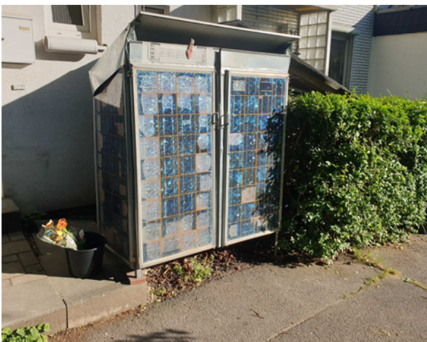
Abb 5 — Hier wurden alte Solarmodule für den Bau eines Gemüse-Fairteilerschrankes für Foodsharing genutzt • Foto: SFV
