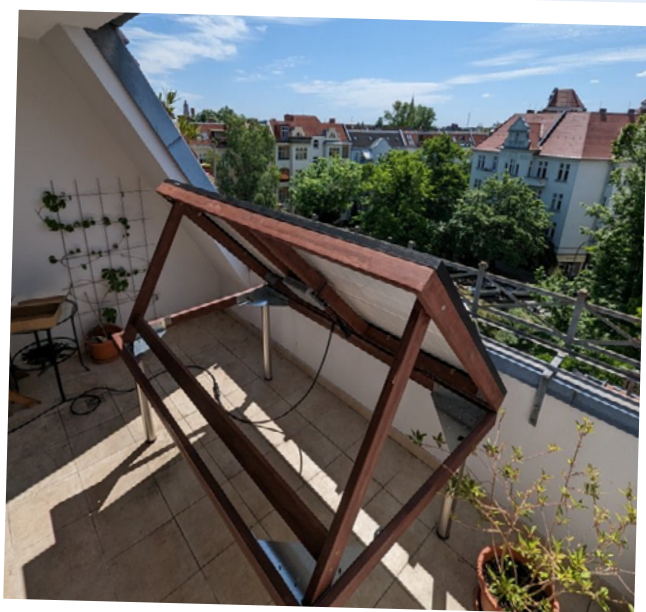
Abb 3 — Ein aufklappbarer Solartisch kann auch aus Ü20-Modulen gebaut und als Steckersolaranlage betrieben werden. • Foto: Balkon.Solar e. V.
